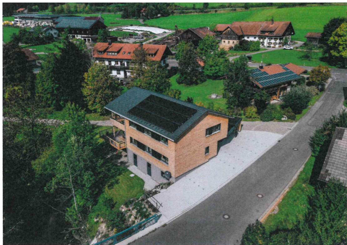
Auf dem Dach des Hauses befindet sich eine Photovoltaikanlage mit einer Leistung von 8,4 Kilowatt peak
