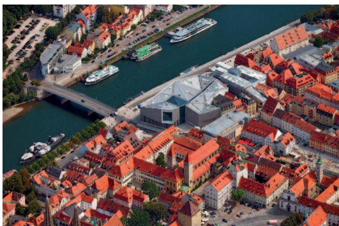
© Staatliches Bauamt Regensburg | Foto: Nürnberg Luftbild Hajo Dietz
