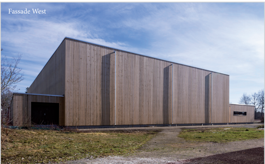
Montage Tannenfassade auf „TES“-Elemente Fotos: Herz & Lang GmbH
