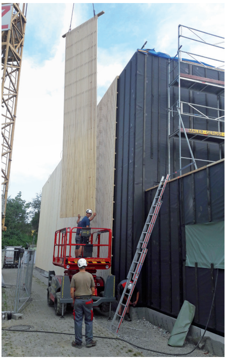
Montage Tannenfassade auf „TES“-Elemente Fotos: Herz & Lang GmbH
