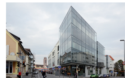
Passivhaus – Ärztehaus, Büros, Bio-Supermarkt, Bistro, Wohnungen
