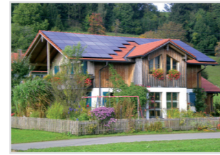
1998: Erstes Passivhaus im Allgäu Vollholzbau mit AEREX-Kompakt-Gerät
