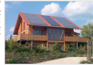
2001: Erstes PassivhausPlus Holzrahmenbau mit Solarthermie und Photovoltaik
