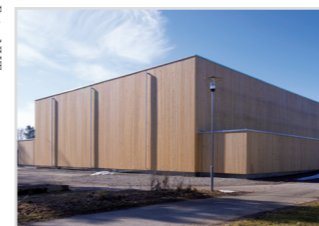
2016: Sanierung einer Dreifachturnhalle mit Passivhaustechnik, 1400 m² vorgefertigte Holzbau-Fassadenelemente in Tanne, Architekturbüro Gegenbauer
