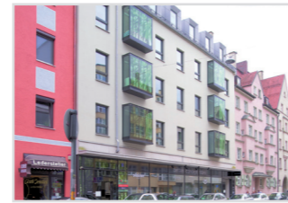
2012: EnerPHit-Pilotprojekt München-Baaderstr., Wohn- und Geschäftshaus, Architekt Fink / München
