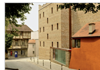
2013: Kunstmuseum Ravensburg, Architekten LRO/Stuttgart, erstes Passivmuseum weltweit, mit einer Vielzahl von Preisen, Passivhaus-Pilotprojekt mit GU REISCH GmbH/Bad Saulgau
