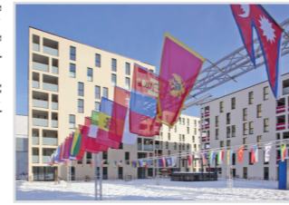
2011: Olympisches Dorf Innsbruck, Neue Heimat Tirol, Jugendolympiade 2012, sozialer Wohnbau mit 444 WE, seit 2011 ist das Passivhaus Baustandard der NHT
