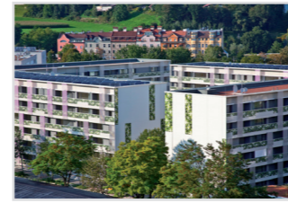
2009: Lodenaareal Innsbruck, Neue Heimat Tirol, 345 WE, das größte PHI-zertifizierte Wohnbauprojekt weltweit
