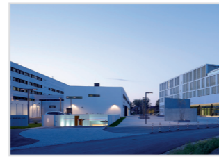
2012: Justizzentrum Korneuburg, erstes Gerichtsgebäude und Vollzugsanstalt im Passivhausstandard, Staatspreis für Architektur und Nachhaltigkeit, Architekten Mathoi + din a 4
